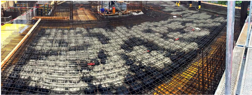
Une dalle en béton armé Cobiax SL en cours de construction lors du premier bétonnage.
