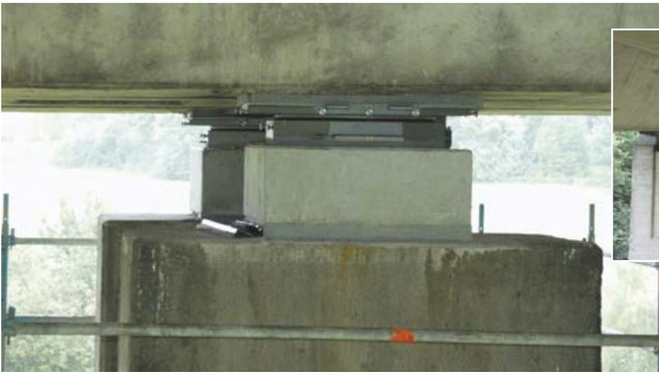
Renforcement de la base des piliers d'un pont autoroutier.
