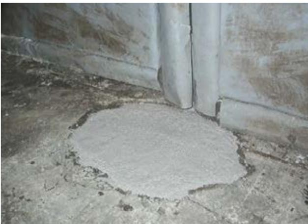
Réparation du sol d'une chambre froide en fonctionnement avec le mortier Silikal R 17 (-25 degrés C).
