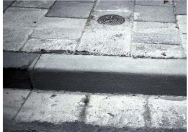
Réparation de jointure de zone piétonnière en pierre avec le mortier Silikal R 17.
